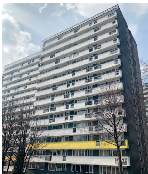
Ukończony w 2020 roku remont elewacji z zadaszeniem ostatniej kondygnacji budynku przy ul. Chrobrego 32
