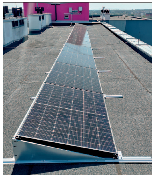
ul. Tysiąclecia 19 – montaż instalacji fotowoltaicznej
