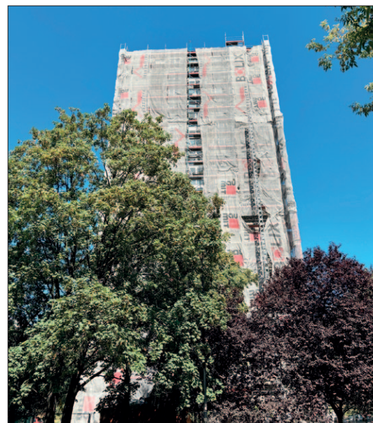
ul. Bolesława Chrobrego 9 – termomodernizacja elewacji
