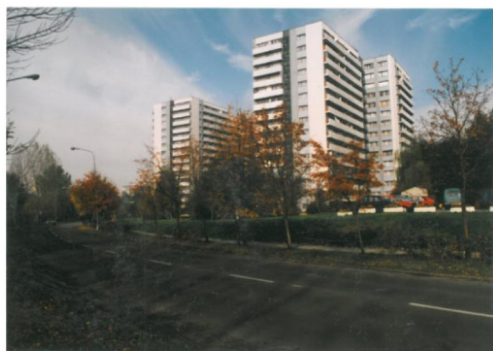
Widok od strony ulicy
