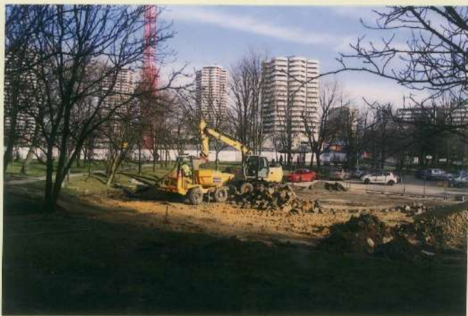
Przygotowanie terenu pod parking.
