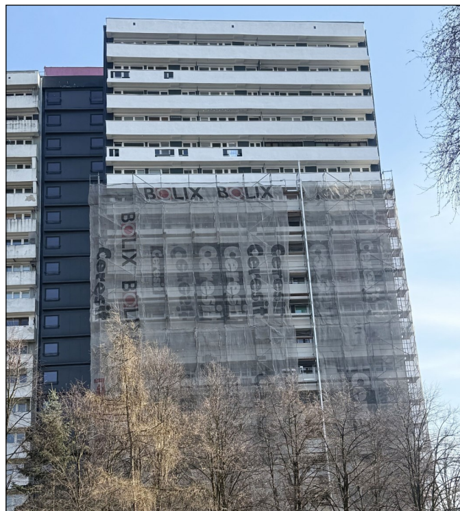
Tysiąclecia 78 - remont elewacji
